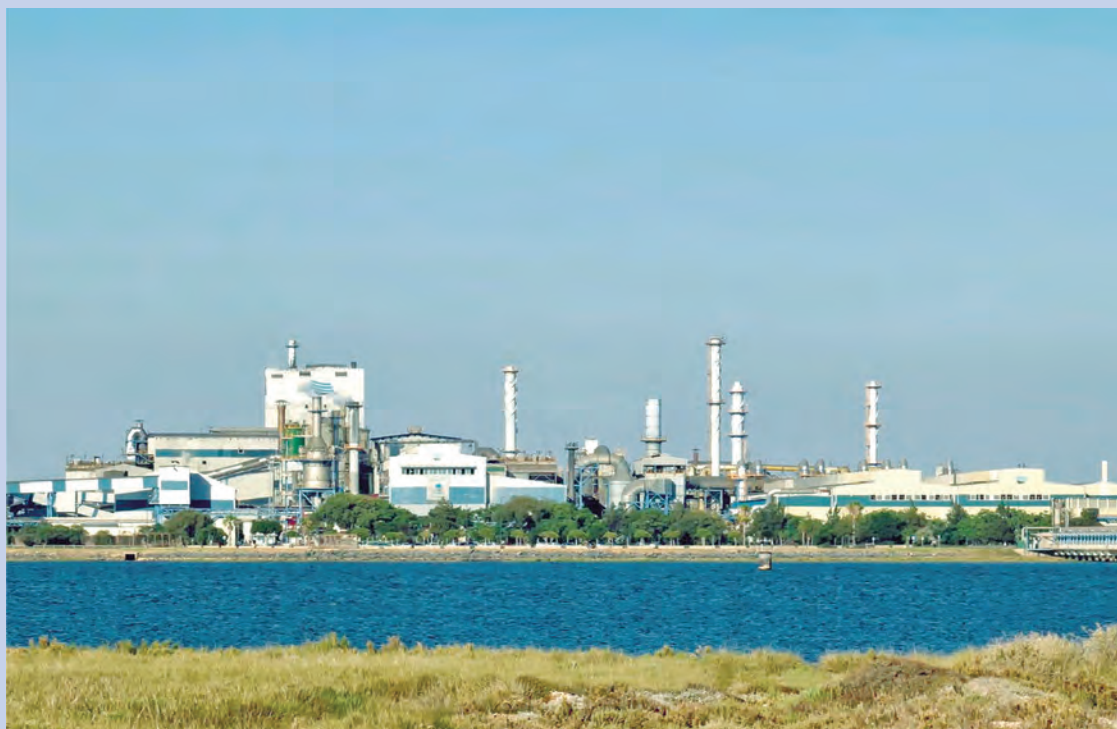
Instalaciones de Atlantic Copper en Huelva.
