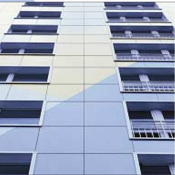
Fachada ventilada de chapa de aluminio lacado.
