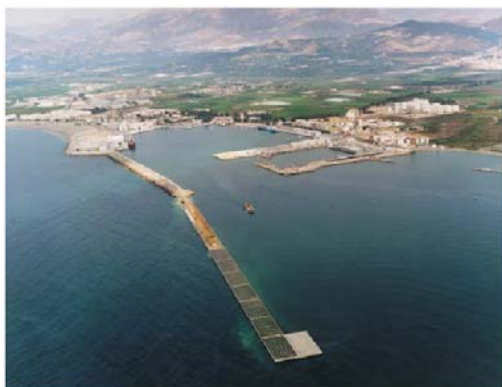
Fotografía 1.- Construcción de un muelle con cajones flotantes.
