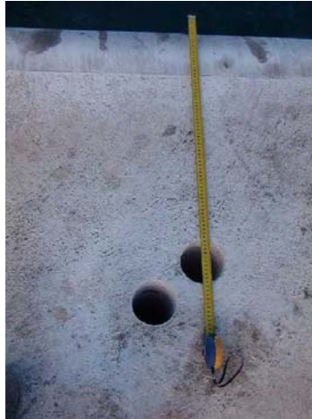
Fotografía 3.- Realización de sondeos en los muelles.
