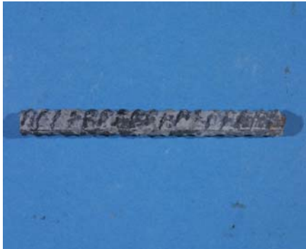
Fotografía 4. Armadura sin corrosión.
