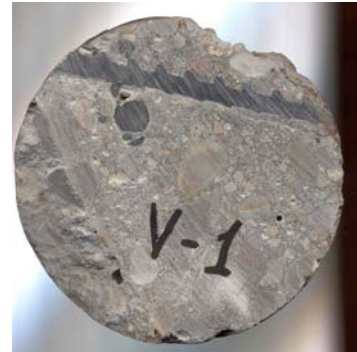
Fotografía 5. Armadura sin corrosión.
